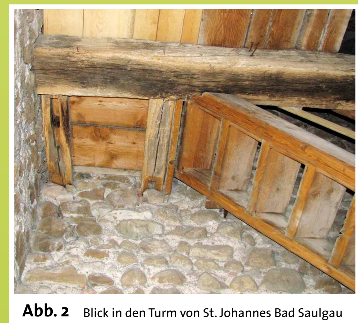
Abb. 2 Blick in den Turm von St. Johannes Bad Saulgau
